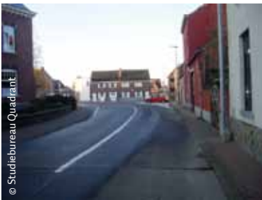
De oorspronkelijke toestand met een onaangepast en onduidelijk wegprofiel
